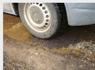
Suru tasandatud segu plaatvibraatori või käsitambiga kokku või tihenda autorattaga üle sõites.
