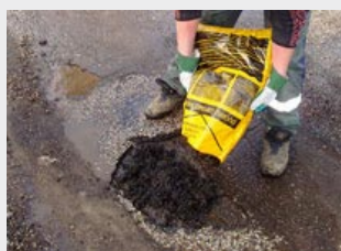
Kalla segu otse kotist eelnevalt puhastatud auku.
