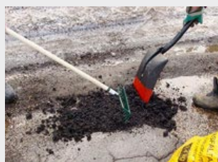
Tasanda pind labida või rehaga ühtlaseks nii, et segu jääks ülejäänud teepinnast veidi kõrgemaks.
