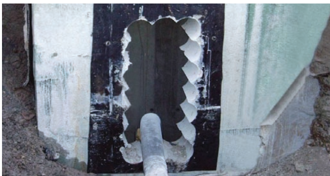
Kõrgpinge kaablite ja kanalite sisend peab olema isoleeritud seina võllis.
