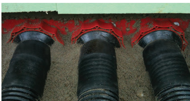
lainelistele torude ühendus kasutades külmkahandamismeetodit HSI 150-D 110-KS.
