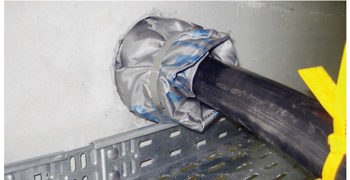
HSS – paigaldus puuravades koos HRD survetihendiga.
