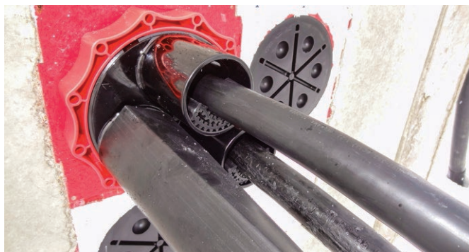
Topeltseina seinatükk HSI 150 fikseeritud pakina raketisse.
