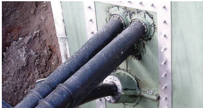
Lahutatud kinnine/lahtine äärik vastavalt DIN 18195.
