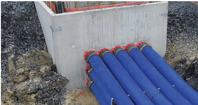
KES-M 90-D – ühendus HSI 90 seinasisendiga.
