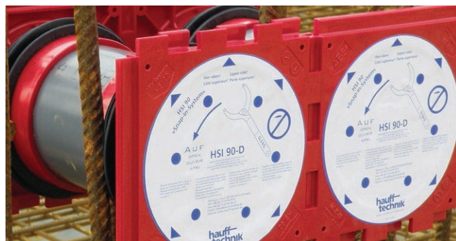
Topeltseina seinasisend HSI 90 fikseeritud kompaktselt raketisse.
