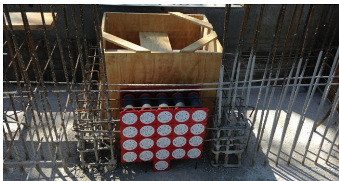
Topeltseina seinasisendi HSI 90-K2 kokkupanek enne betoneerimist.
