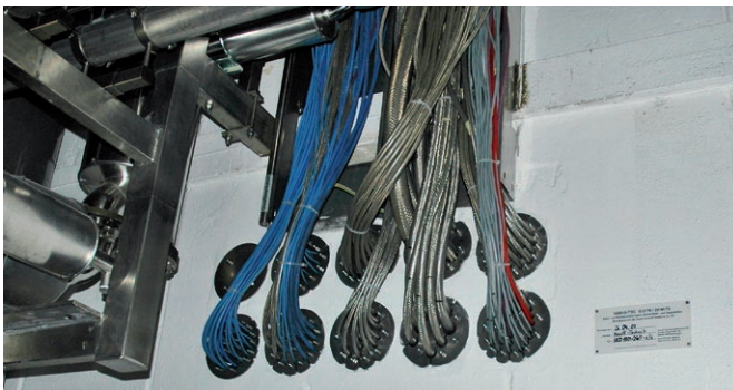
P-CABLE Professional 2: HRD 150-1G mitmete kaablite tihendamine ühes puuravas/seinahülssis.
