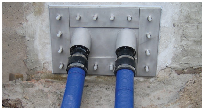
Kinnine/lahutatud äärik ühekülgse tühivooliku ühendusega ja pindmise isolatsiooniga.
