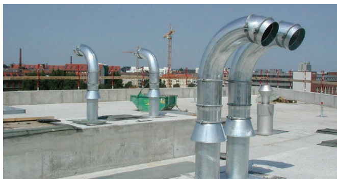
Paigaldatud SHD 200 enne kaablite asetust.
