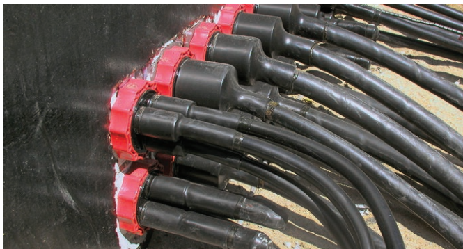
Transformaatoripunkti sisend: madalpinge kaablid tihendatud HSI 90-D1/75 ja HSI 90-D3/32.
