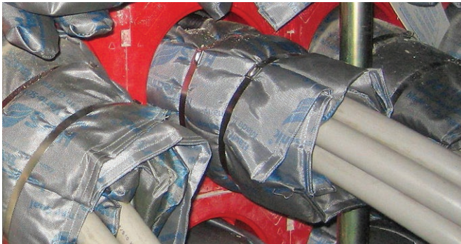
HSS – tulekaitse paigaldus seinasisendis HSI 150-K2, Isolatsioon süsteemi kattega või SEGMENTO'ga.
