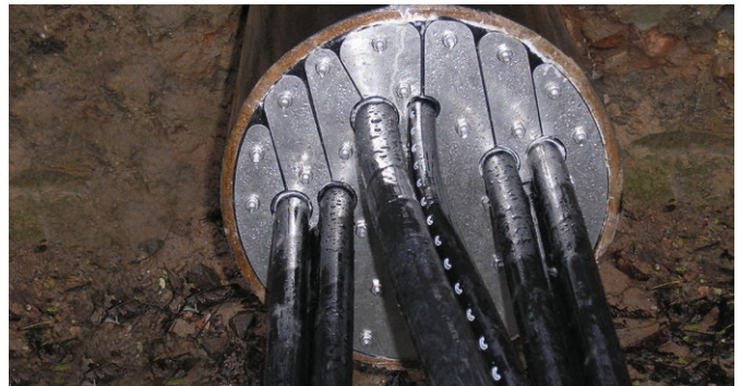
P-CABLE Professional 2: HRD 200-1G paigaldatud terastorru.
