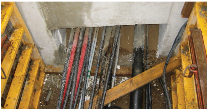
Olemasolev nelinurkne ava tuleb järgnevalt isoleerida.
