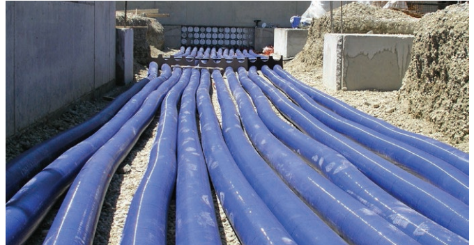
Paindlike kaablisendite süsteemid – vajadusel saab ka pikendusi.
