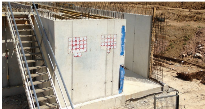
HSI 90-K2 pärast betoneerimist: tühjad kanalid paigaldatakse hiljem.
