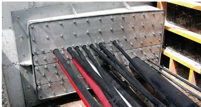
Nelinurkne lahutatud äärik mitmele kaabli läbiviigule.
