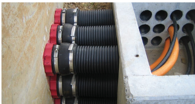
lainelistele torude ühendus kasutades külmkahandamismeetodit HSI 150-M 168.
