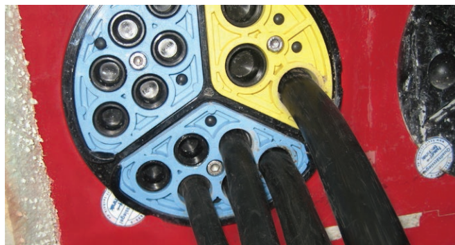
HSI 150 – SEGMENTO - tervikliku pöördemomendi kontrollisüsteemiga ja korkidega.
