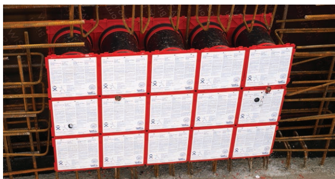
Topeltseina seinatükk HSI 150 fikseeritud pakina raketisse.
