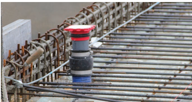
KES-M 90-KVB – paigaldamine plaatidel.
