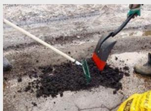
Разравнивайте поверхность с помощью лопаты или граблей так, чтобы смесь осталась немного выше от поверхности дороги.
