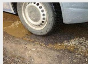
Надавите на смесь лопатой, пластинным вибратором или проедьте по нему автомобильным колесом.
