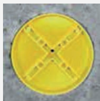
Kaitsekate pärast betoneerimist
