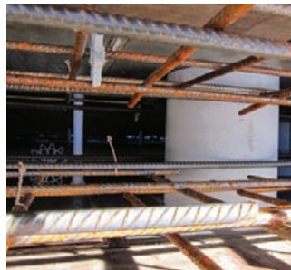
P-LINER Basic ZVR 200/300 konstruktsiooni paigaldatuna
