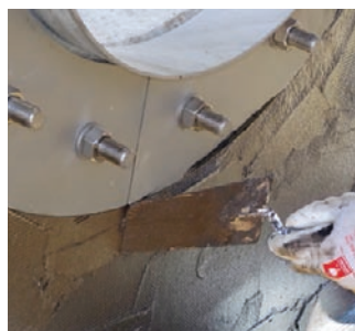
P-LINER Professional 2 HRD 300-FUF/300 roostevaba teras ühendatud PMBC-ga läbi fliisist tekstiili, vt lk 37
