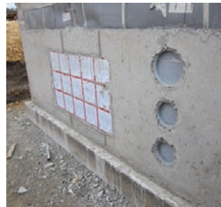
P-LINER Basic ZVR 150/300 ja ZVR 200/300 betoneeritud HSI 150 kõrvale
