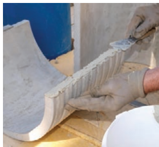
P-LINER Basic 3 FZR-G 350/300 koos paigalduskomplektiga
