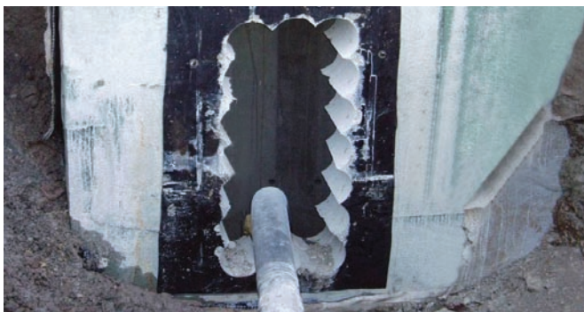
Kõrgepingeliinide ja -kanalite sisestuseks on vajalik teostada esmalt ava süvistamine.
