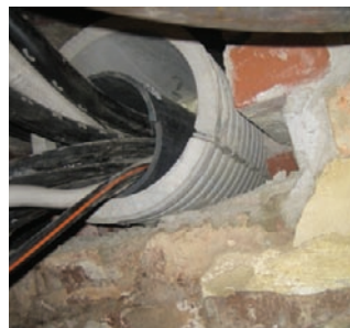
P-LINER Basic 3 FZR-G 150/350 renoveerimistööd tellistest ehitatud seinas
