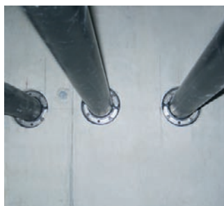
P-PIPE Basic 1 HSN 125/75 toruühendused
