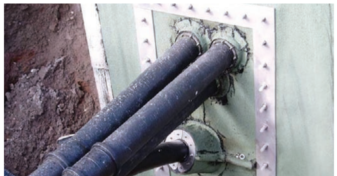
Avause erilahendus fikseeritud/lahtine serv, vastavalt DIN 18195-le.
