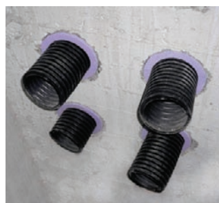
Vaade maja seest poolt (isolatsiooni rõngad)
