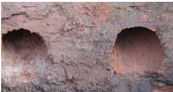
Kaldus puuraugud poorses seinas.
