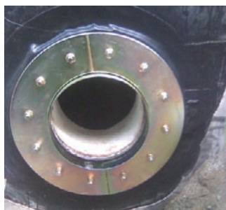
P-LINER Professional 4 HRD 400-FUFA-vz torustiku ühendus
