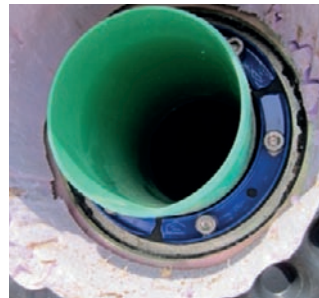
P-PIPE Basic 5 HSD-C 150/110 Fikseeritud/lahtine äärik, galvaniseeritud versioon
